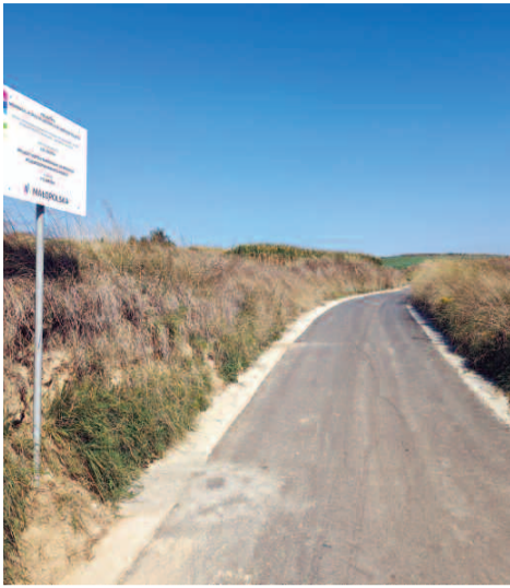
Droga dojazdowa w miejscowości Obrażejowice - Gąsawy Góra
